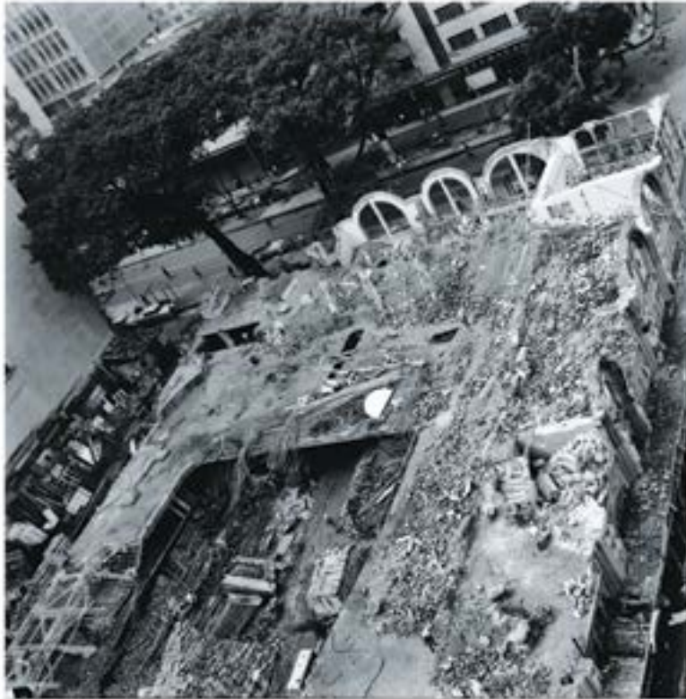
Demolición del Teatro Junín - 1968 - Digar - Archivo Biblioteca Pública Piloto
